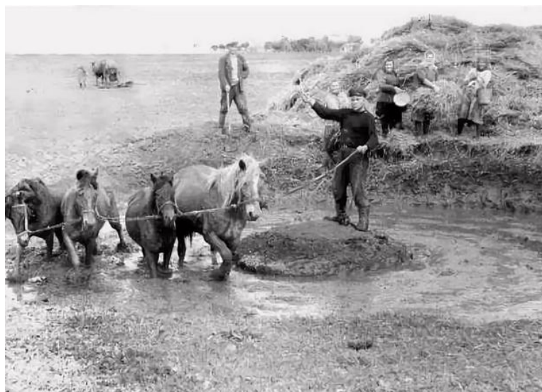
Рис. 3. Замешивание самана при помощи лошадей
